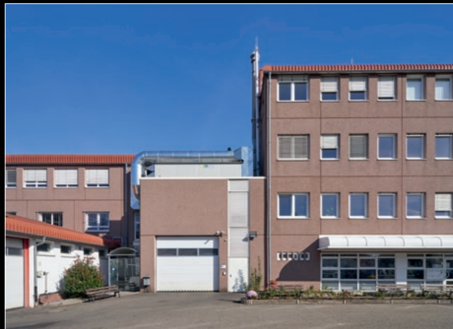
Moderne Architektur mit durchdachter Gebäudetechnik: Der Firmensitz von Bauer-Walser.
