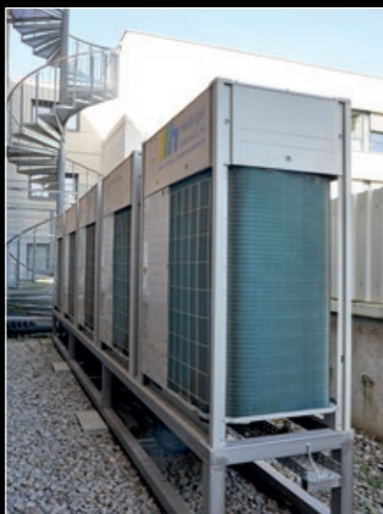
Perfekt angepasst: Temperierung des Gebäudes mit Wärmepumpentechnik.
