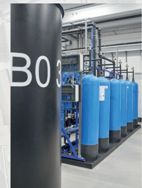
Alles sauber: Im Neutralisationsbereich werden die Galvanikmedien aufbereitet und recycelt.
