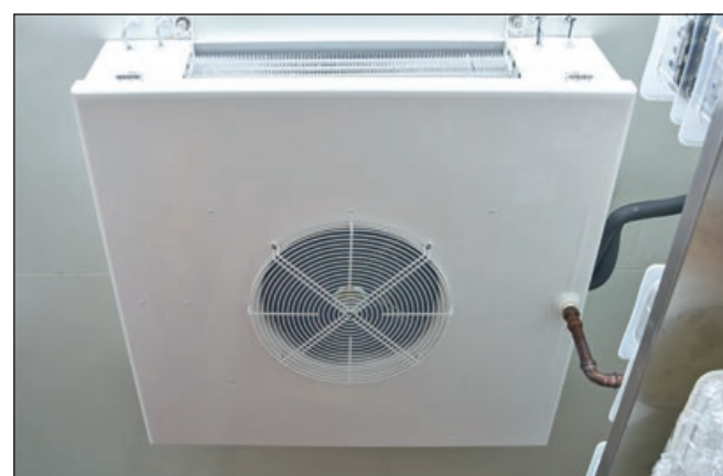
Luftkühler, speziell ausgelegt für hohe Drucklagen.
