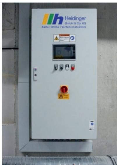
Durchdachte Technik von Heidinger: Fernüberwachte Zentralsteuerung der OP Lüftung.
