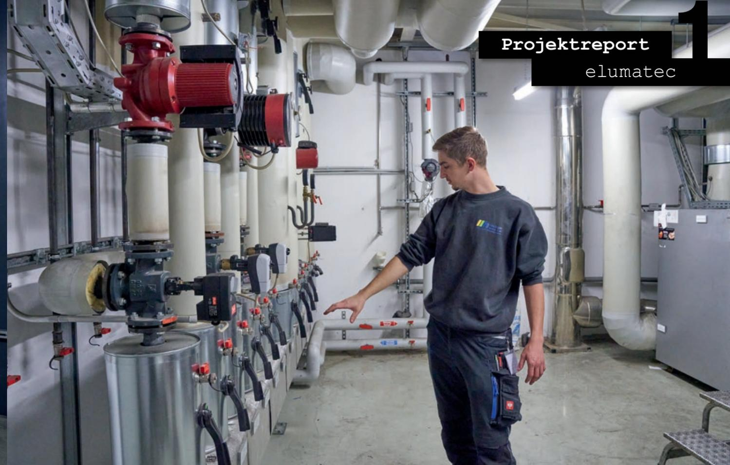
Eine echte Herausforderung: Aufgesetzt auf den Bestand, galt es vorhandene Systemkomponenten, wie Druckluftkomponenten und Heizungstechnik in die neue GLT zu integrieren.
